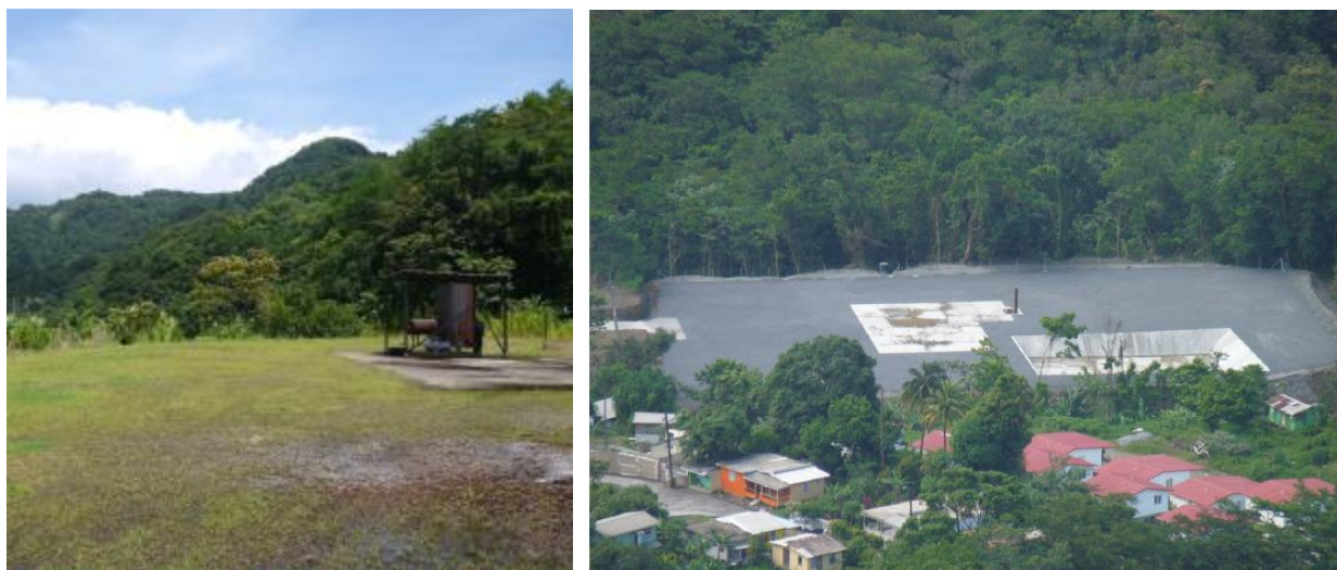
Figure 3.9 : Site WW-01 (left). View over Trafalgar (WW-R1) reinjection site (right) (Caraïbes Environnement Développement & Coll, 2013)
